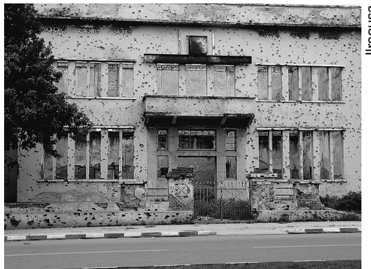
Figura 16.2: Na imagem, registrada em novembro de 2002, pode-se ver um edifício destruído por armas de fogo na província de Huambo.
